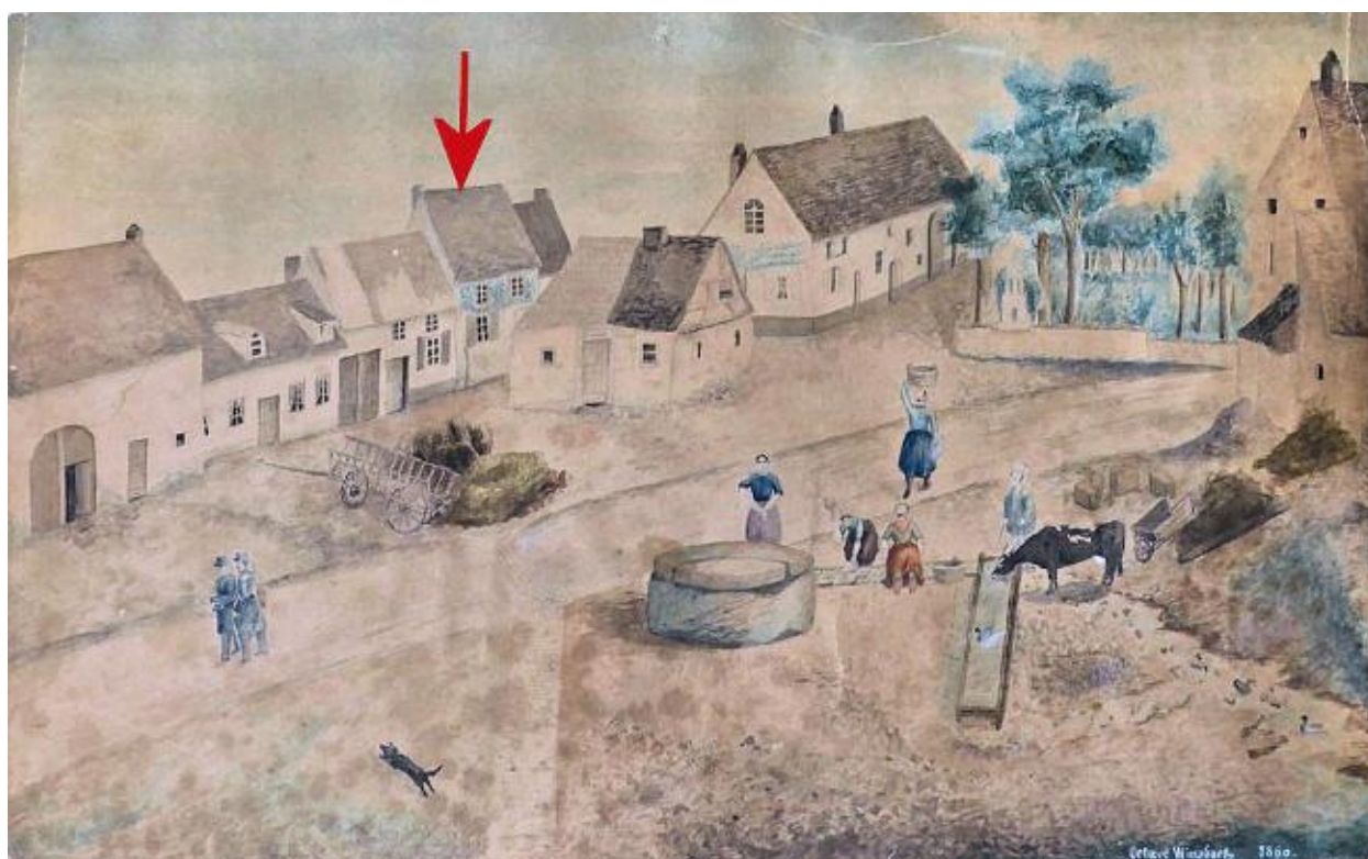
Maison KIRSCH en 1860 « Place de la Fontaine »
